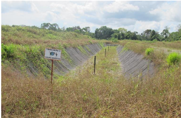
VERTEDERO DE BARU – TRINCHERAS SIN USO
