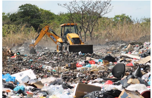
VERTEDERO DE BOQUETE
