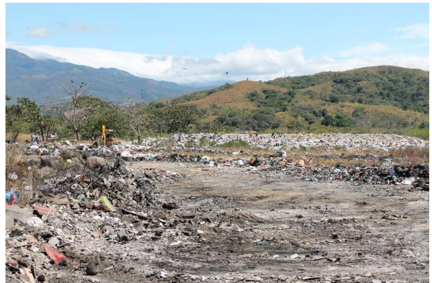
VERTEDERO DE BOQUETE
