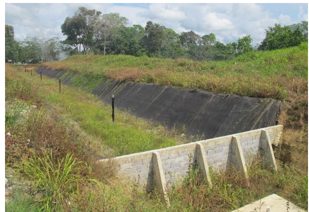
VERTEDERO DE BARU - TRINCHERAS
