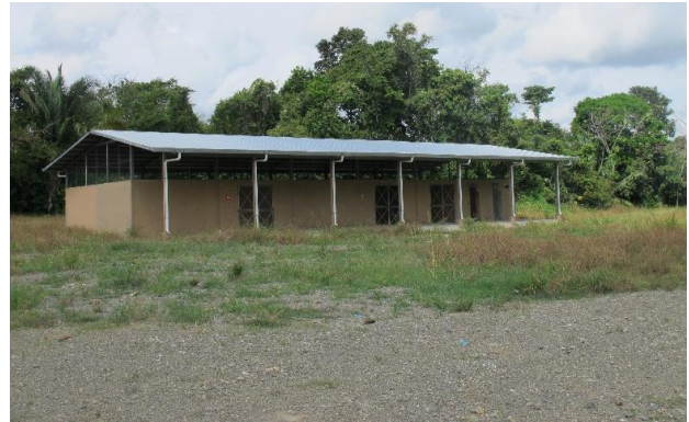
VERTEDERO DE BARU – GALERA DE RECICLAJE CLAUSURADA
